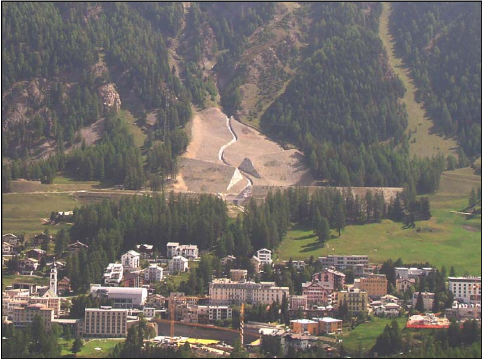
Figure 15. Ouvrages de protection contre les avalanches et les coulées de débris à Pontresina
