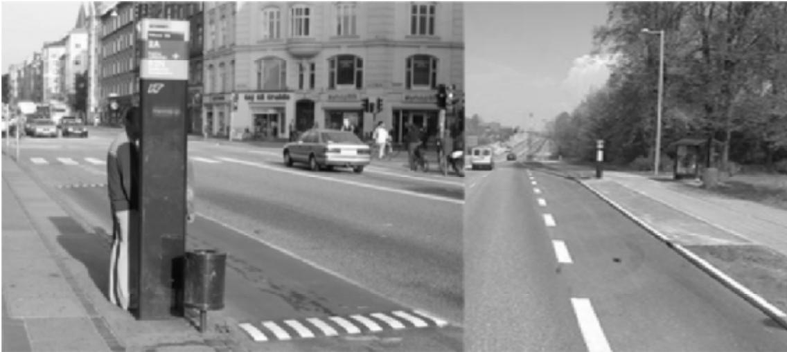
Gauche : Piste cyclable avec ralentisseurs à l'arrêt de bus. Droite : Arrêt d'autobus avec îlot piéton entre la zone d'arrêt de l'autobus et la piste cyclable.
