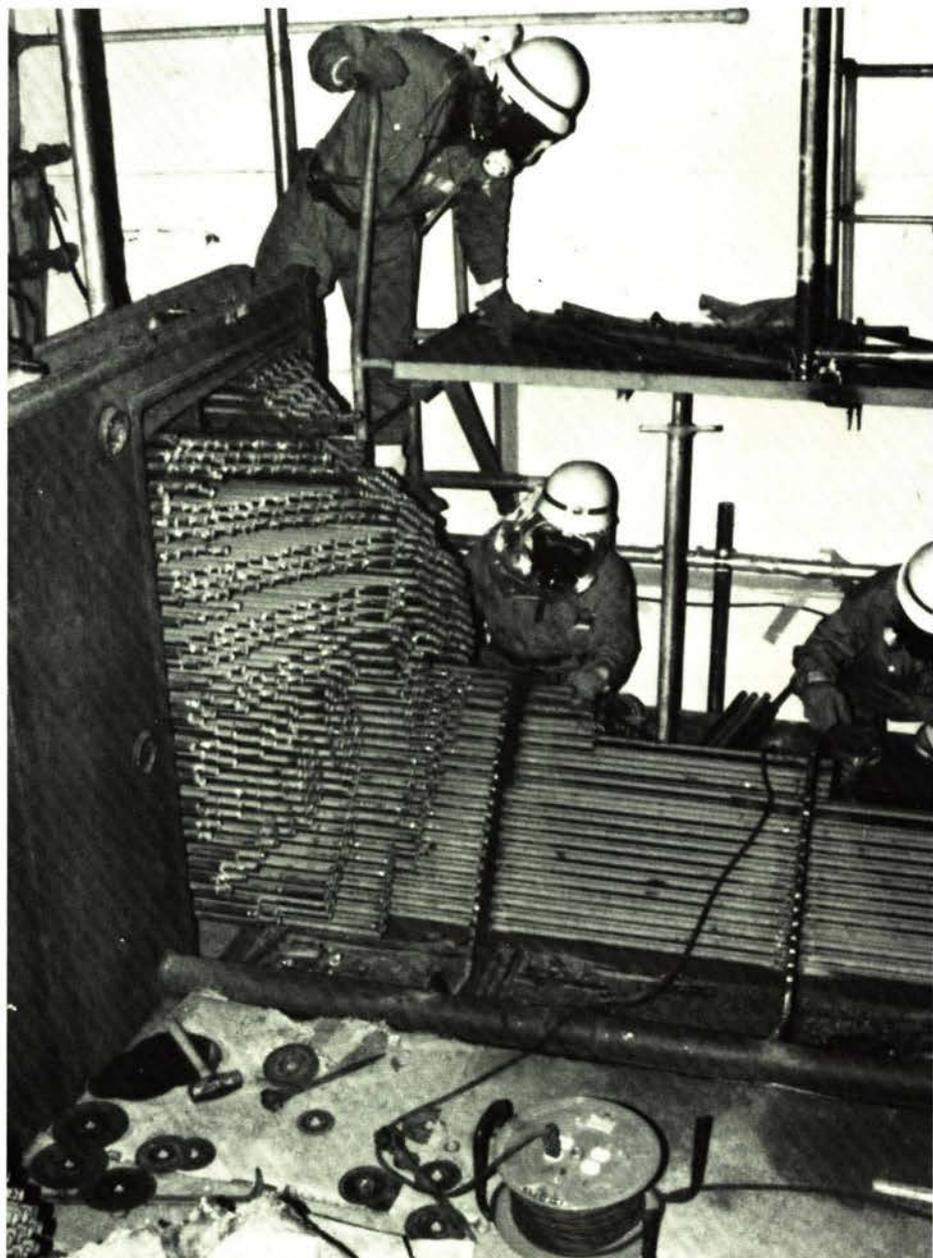
*Les premières phases du déclassement: à l'aide d'une scie électrique on ôte les tuyaux de refroidissement.*
