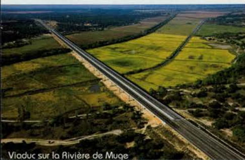
Viaduc sur la Rivière de Muge
